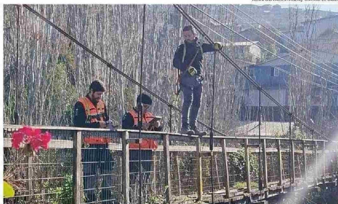
EL DESPLIEGUE DE LOS EXPERTOS EN EL PUENTE COLGANTE HA LLAMADO LA ATENCIÓN DE LOS VECINOS.
