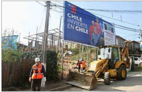
POSTURA. — La dueña de una vivienda afectada aseguró a este medio que aceptó demolerla “para no quedar en el limbo” o en situación indefinida.
