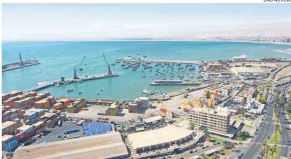
EL PLAN DE EMERGENCIA HABITACIONAL AUMENTÓ LA CONSTRUCCIÓN, PERO EL PROBLEMA PERSISTE.
