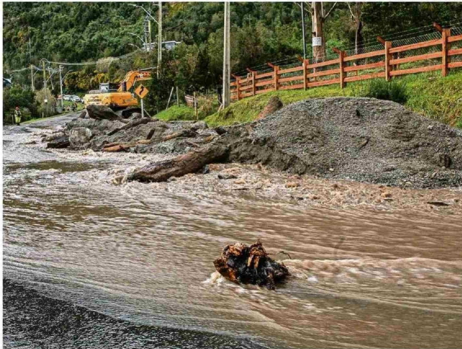
LABORES DE LIMPIEZA Y DESPEJE DE LA RUTA, EN UN TRAMO DE 200 METROS, REALIZARON AYER EN EL SECTOR DE CHAICAS, EN LA CARRETERA AUSTRAL.
