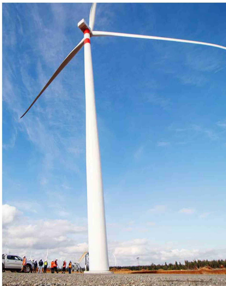
Tres aerogeneradores ya se encuentran conectados a la red.
