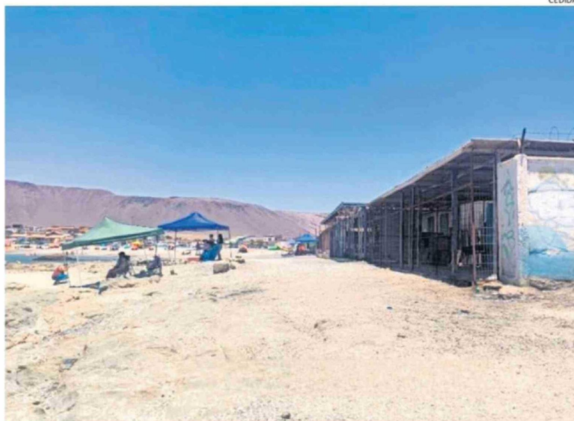
COMUNIDAD DENUNCIA QUE ESTAS CABAÑAS NO ESTÁN CONECTADAS AL ALCANTARILLADO.
