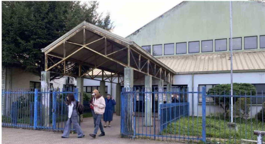
EL SERVICIO DE REFERENCIA ONCOLÓGICO DE LA PROVINCIA ESTARÁ UBICADO EN EL EDIFICIO DEL CESFAM DE RAHUE ALTO, EN AVENIDA REAL.
