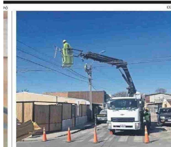
EQUIPO TRABAJANDO EN TERRENO.
