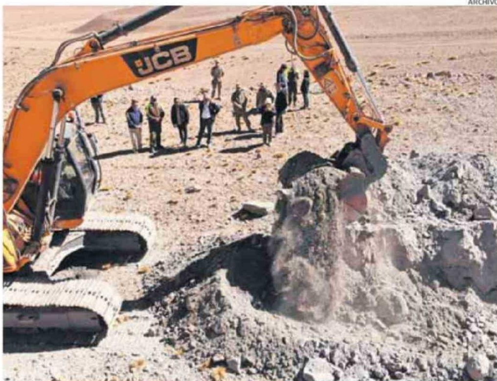
HOY COMENZARÁN LOS TRABAJOS DE LA BRIMOT EN LA CONSTRUCCIÓN DE LA ZANJA EN LA COMUNA DE OLLAGÜE.
