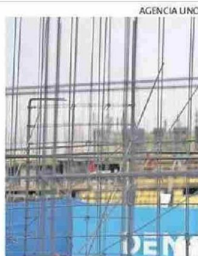
TRABAJO EN CONSTRUCCIÓN.
