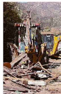
TRABAJARON EQUIPOS MUNICIPALES.
