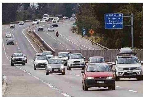
PARTE DE LAS OBRAS SE REALIZARÁN EN LA REGIÓN.
