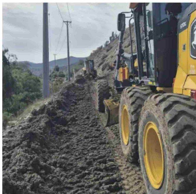
En las rutas dañadas se ha comenzado los arreglos con maquinaria pesada.
