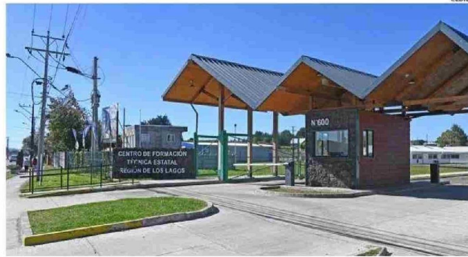
PRÓXIMAMENTE INICIARÁ LA CONSTRUCCIÓN DE LA TERCERA ETAPA DEL CAMPUS CASA CENTRAL EN LLANQUIHUE.
