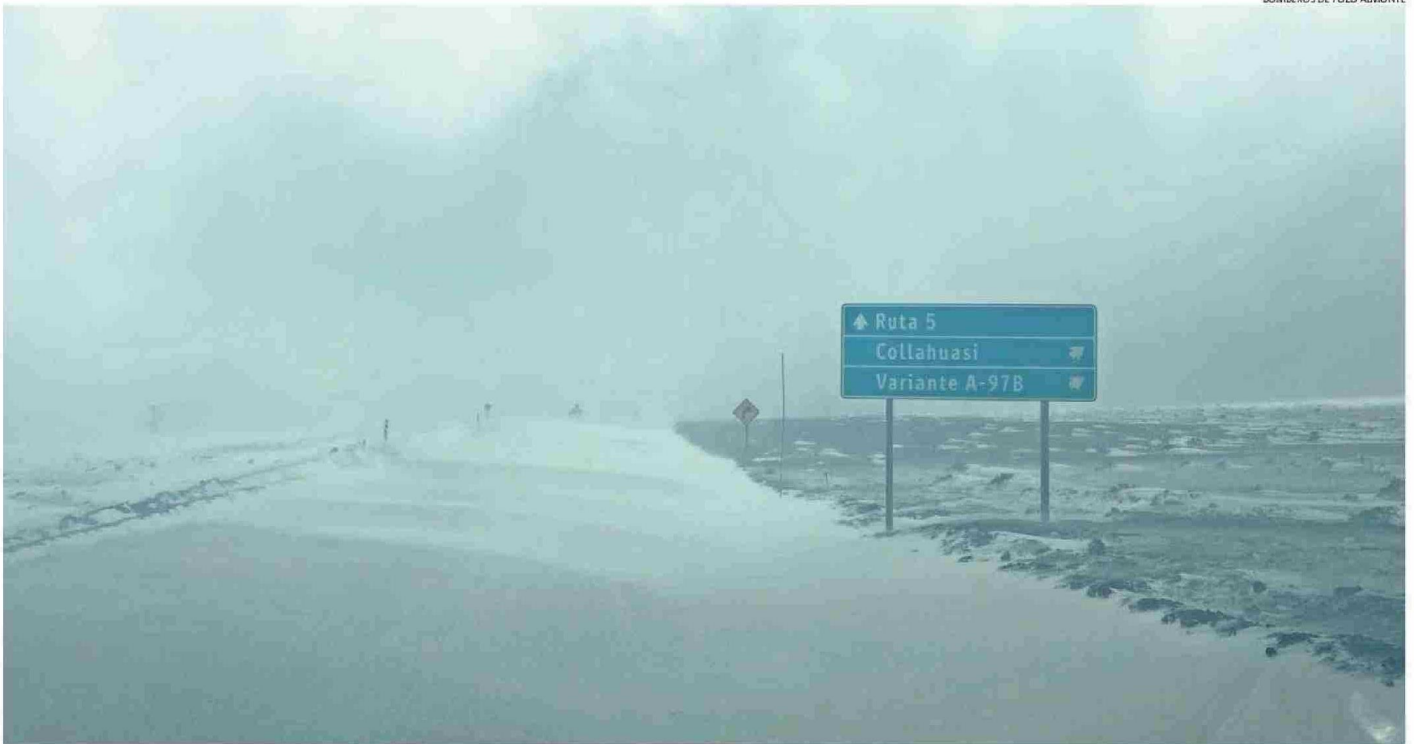
EN LA RUTA 5 HUBO UNA FUERTE NEVACIÓN. ASÍ LUCÍA LA CARRETERA AYER POR LA TARDE.
