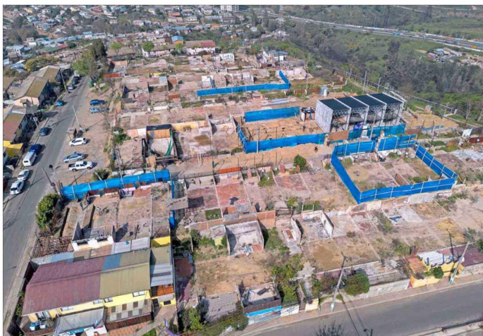
INVERSIÓN DE $4 MIL MILLONES. —Las 52 casas en modalidad de cuatripareo tendrán cada una 62 m² distribuidos en dos pisos. Según el Serviu, con alto estándar de habitabilidad, ventanas termopanel y revestimientos.
