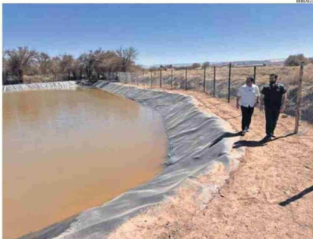
OBRAS HIDRÁULICAS PERMITIRÁN A LOS AGRICULTORES PODER HACER UN USO EFICIENTE DEL AGUA.
