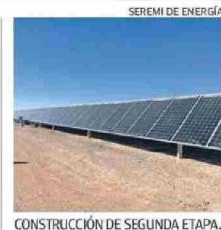
CONSTRUCCIÓN DE SEGUNDA ETAPA.
