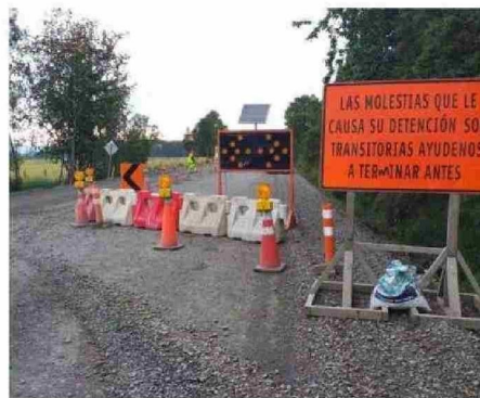
DENTRO DE LOS PRÓXIMOS MESES SE INSTALARÁN NUEVOS LETREROS.
