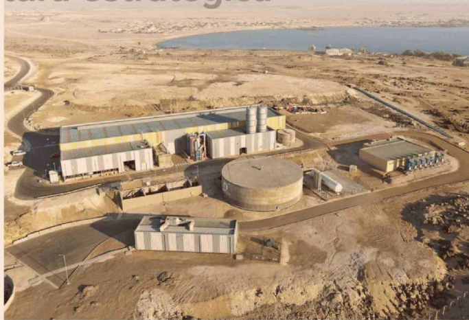
Planta Desaladora de Nueva Atacama en Caldera.
