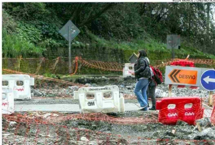
DEBIDO AL ESCURRIMIENTO DE AGUAS SUBTERRÁNEAS, SE REFORZARÁ LA BASE COMPACTADA DEL PAVIMENTO.
