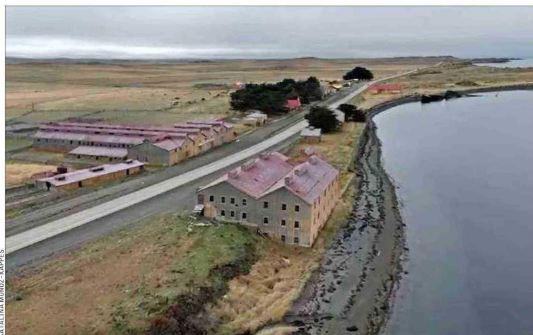
Vista aérea de la Estancia San Gregorio, donde se observa el camino por ensanchar. En la costa, al fondo, están los restos de los buques "Ambassador" y "Amadeo".
