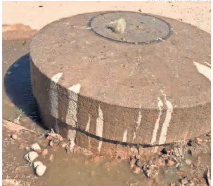
CAPTURA DE VIDEO DE UNA DE UNA DE LAS CÁMARAS SÉPTICAS FILTRANDO AGUAS SERVIDAS.
