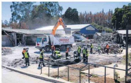
La escuela tuvo que ser demolida para levantar el recinto modular.
