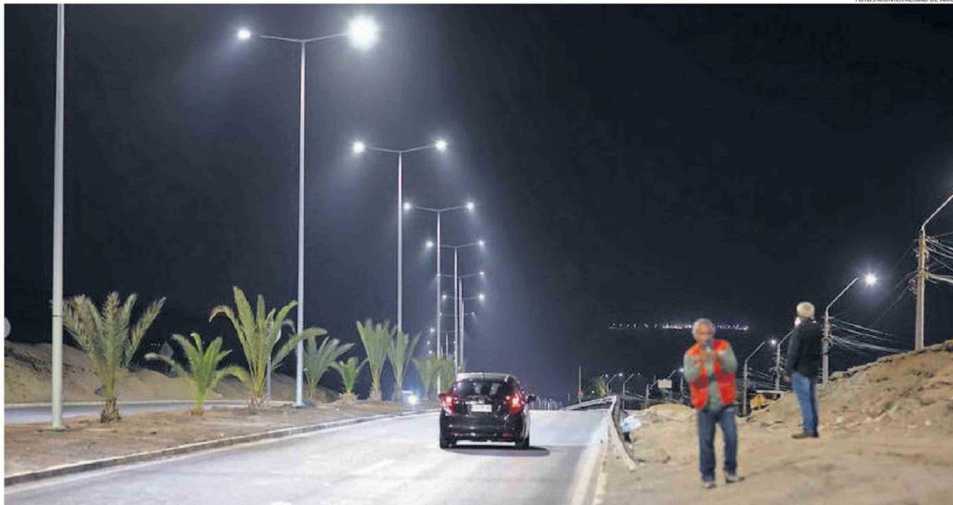
EL PROYECTO, FINANCIADO POR EL GOBIERNO REGIONAL, CONTEMPLA UNA INVERSIÓN SUPERIOR A LOS $1.407 MILLONES E INCLUYE LA INSTALACIÓN DE 168 POSTES Y 336 LUMINARIAS LED.
