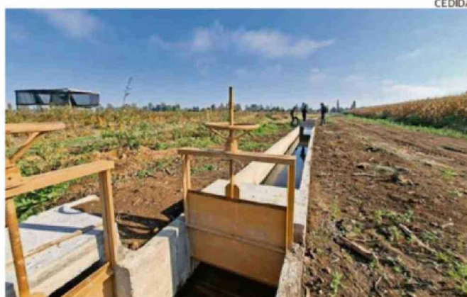
OBRAS ESTÁN ACTUALMENTE EN EJECUCIÓN.
