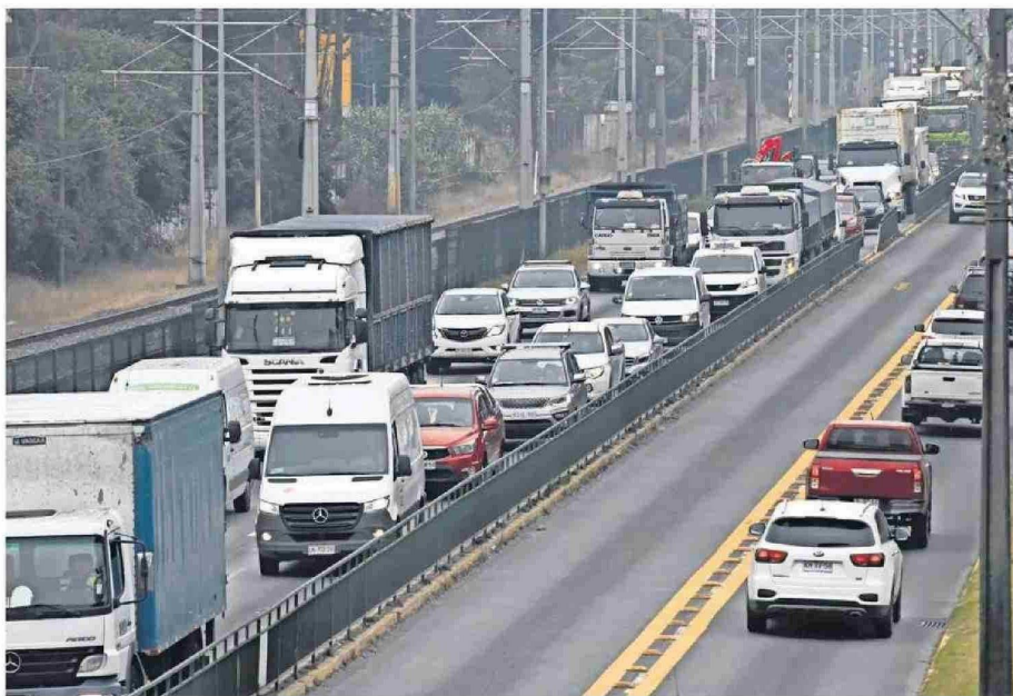
Dos de los megaproyectos consideran descongestionar la ruta 160, entre ellos la construcción de un electrocorredor de 14,2 kilómetros.
