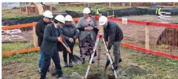
PROYECTO DE SURALIS BUSCA DAR UNA SOLUCIÓN AL COLAPSO DEL ALCANTARILLADO POR AGUAS LLUVIAS.
