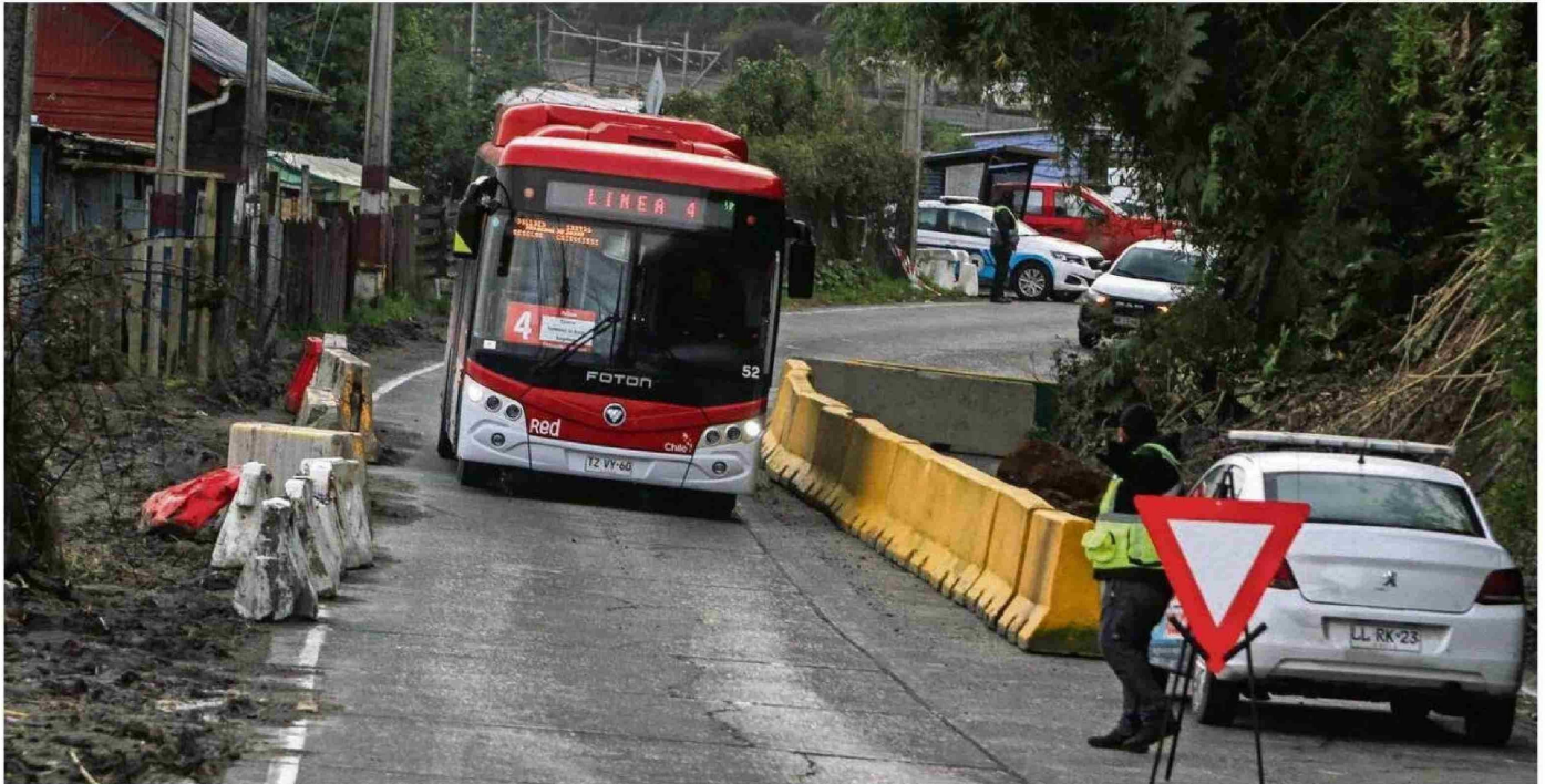
EL 10 DE JUNIO SE PRODUJO EL PRIMER DERRUMBE EN EL KILÓMETRO 10 DE LA RUTA CHINQUIHUE, COMPLICANDO EL DESPLAZAMIENTO DE LAS FAMILIAS QUE VIVEN EN ESE SECTOR DE LA CAPITAL REGIONAL.
