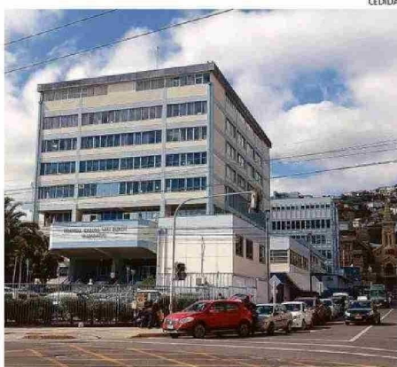
EL RECINTO REQUIERE URGENTEMENTE DE UNA AMPLIACIÓN.
