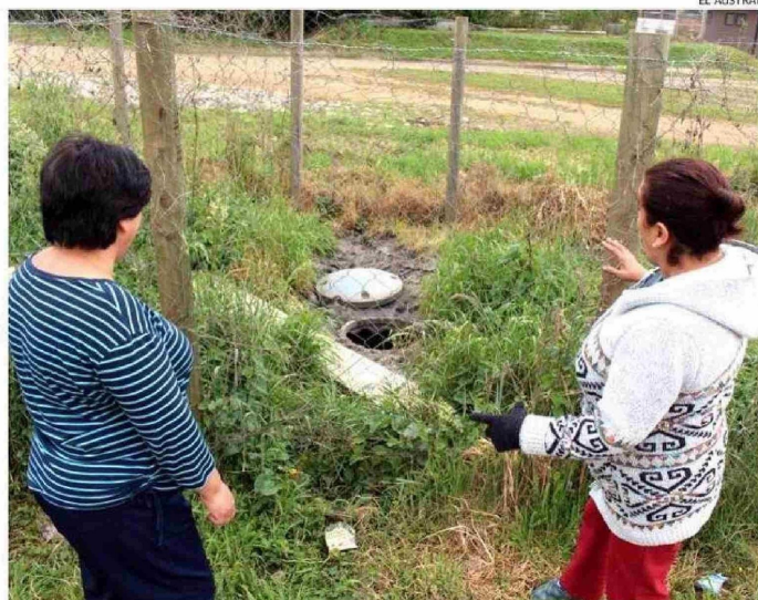
AHORAS SE DESTINARÁ EXCLUSIVAMENTE UN CAMIÓN PARA LA LIMPIEZA DE LA FOSA CON AGUAS SERVIDAS.
