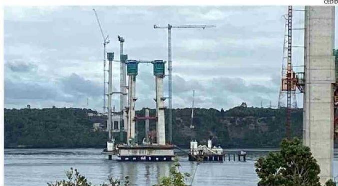
EN EL ACCESO SUR AL PUENTE CHACAO COMENZARÁ EL TRAZADO DE LA VÍA.
