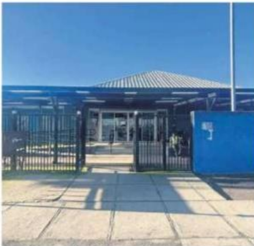
El Cesfam de Hualpén será demolido para construir uno nuevo.
