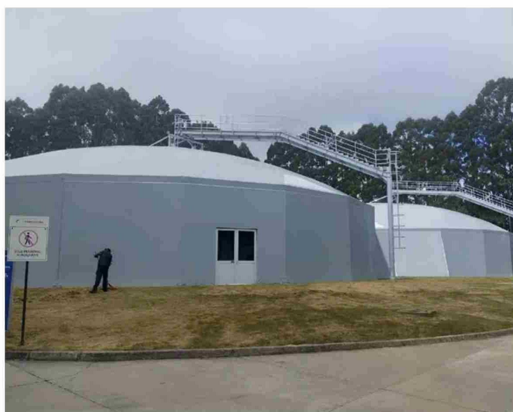
Encapsulamiento de parte de las instalaciones de la estación depuradora de aguas servidas de Aguas Décima, en Valdivia.
