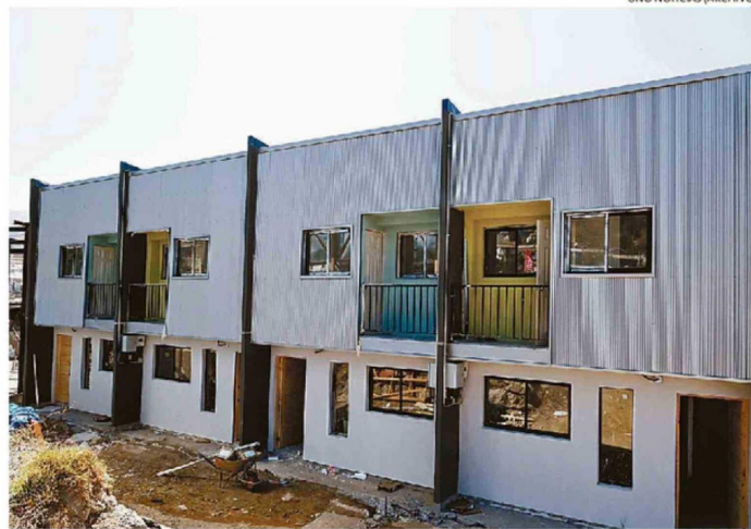
56 VIVIENDAS SERÍAN RECONSTRUIDAS EN ESTE PROCESO, A MÁS DE 2 AÑOS DEL MEGAINCENDIO
