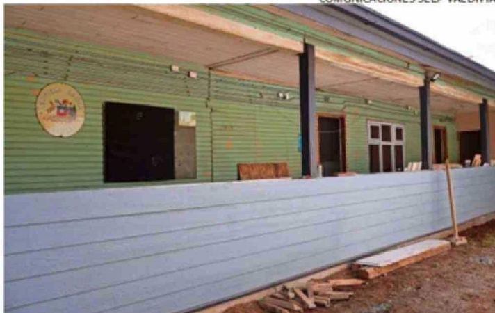
ESTA INICIATIVA ES PARTE DE LAS OBRAS QUE ESTÁ EJECUTANDO EL SLEP.
