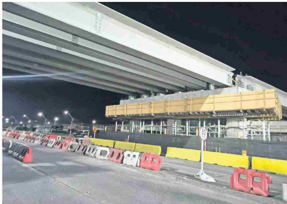
El segundo eje de vigas fue instalado durante la noche del jueves y la maniobra resultó exitosa.
