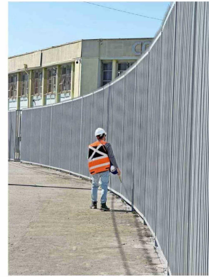
Algunos cambios se vieron de inmediato: cierre perimetral, cámaras, iluminación, guardias, presencia de carabineros en los accesos. El Servicio Local invirtió más de 222 millones de pesos en obras inmediatas.
