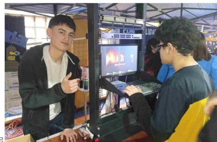
Leo Ponce junto al equipo, aplicando conocimientos en conectividad y redes.
