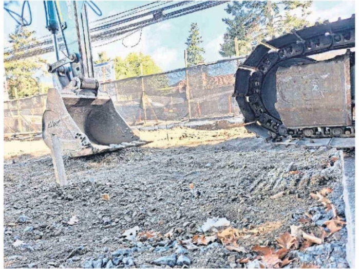
MÁQUINA PESADA POR EL LADO DE LA AVENIDA CHACABUCO, FRENTE A LA CASA DEL ARTE DE LA UDEC.
