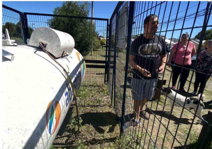
UNO DE LOS VECINOS PUSO UNA CADENA CON CANDADO PARA EVITAR QUE ABRAN NUEVAMENTE LA PUERTA DE ACCESO.
