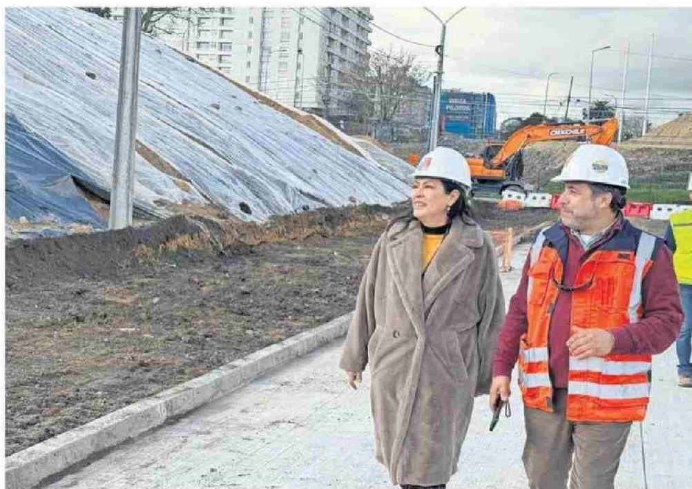
Autoridades han fiscalizado cómo se están ejecutando las obras.
