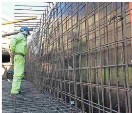
Se está trabajando en la etapa final del colector.
