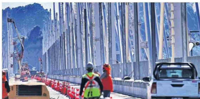
Obras de infraestructura pública son parte de los planteamientos.
