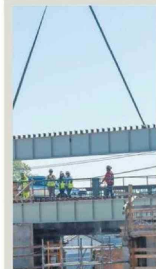
4 PROYECTO Instalan vigas del nuevo Puente Esmeralda
