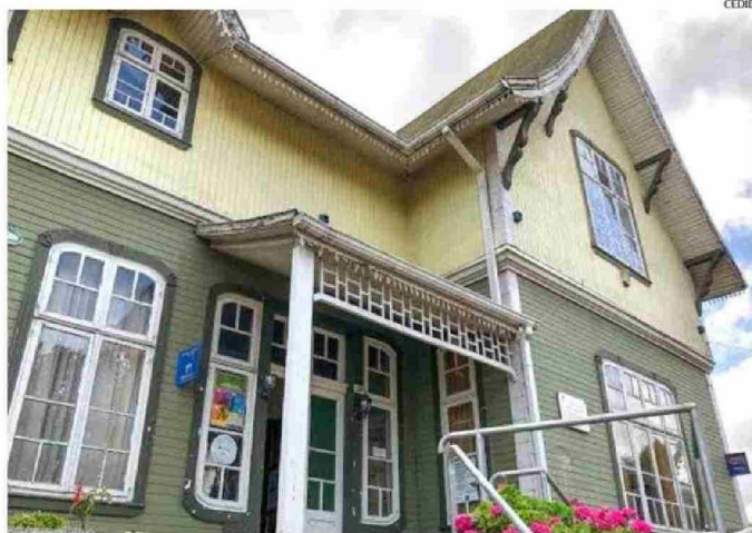
LA BIBLIOTECA MUNICIPAL DE RÍO BUENO FUNCIONA EN LA ANTIGUA CASA PETERS.
