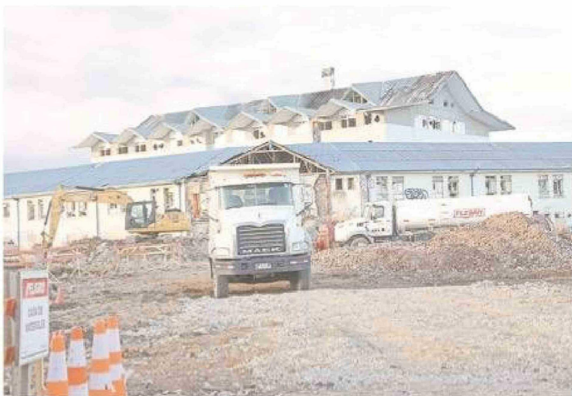
Avanzan las faenas de demolición del exhospital hacia calle Angamos.
