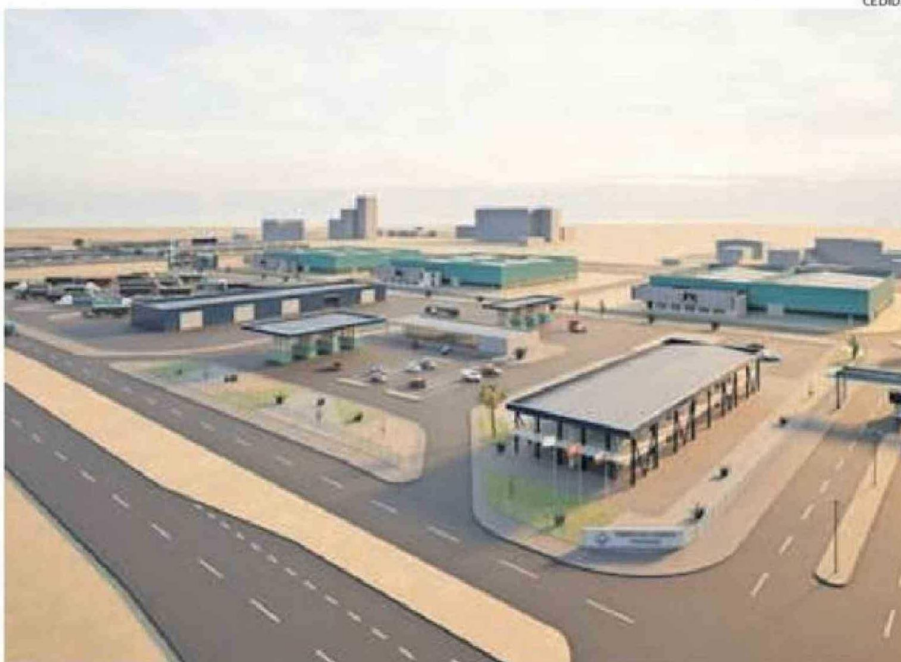
VISTA DEL CENTRO INTEGRADO DE SERVICIOS.
