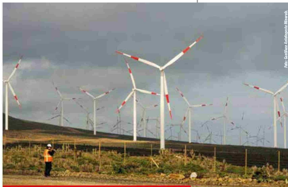
Parque eólico El Arrayán.
