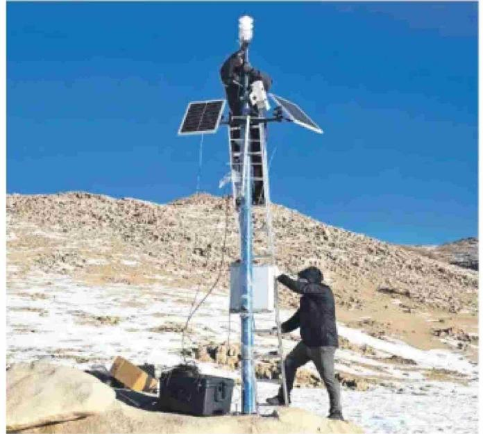
La estación nivométrica recientemente instalada en la subcuenca del río Tascadero se ubica a 3.400 metros sobre el nivel del mar.
